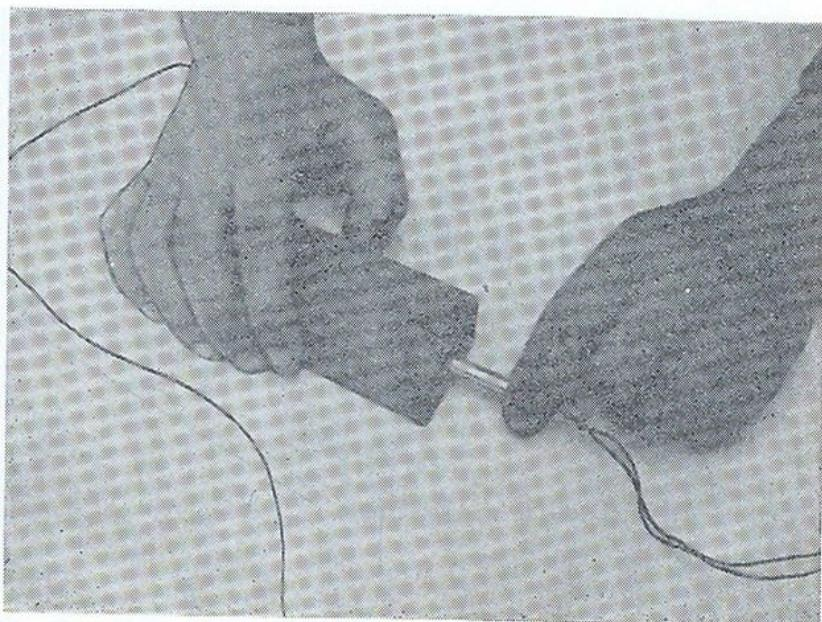
Sl. 68b. Uvlačenje električne detonatorske kapsle u eksplozivno punjenje
